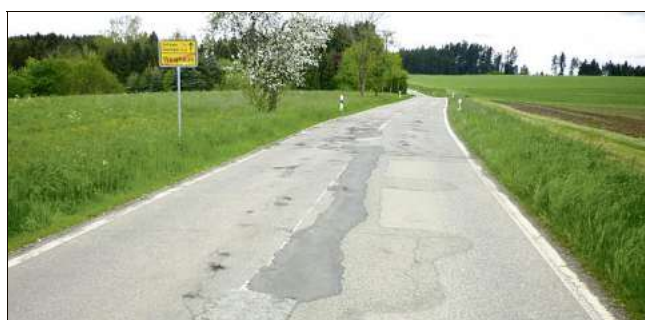
Die Kreisstraßen von Weigheim nach Deißlingen werden repariert. Am Montag geht es los. Foto: Landratsamt Rottweil
